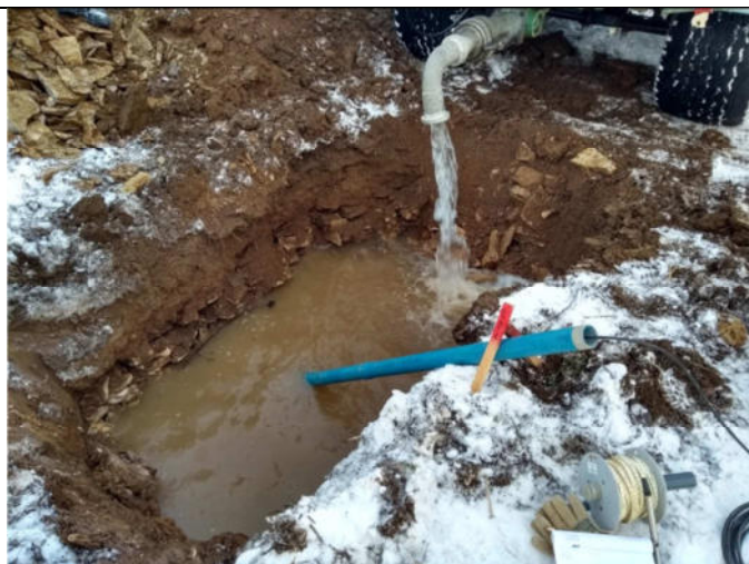
SCH 1: Einleitung von rd. 3.500 Liter in SCH 1
