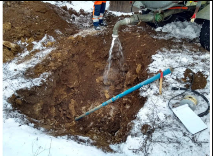
SCH 2: Einleitung von rd. 3.500 Liter in SCH 2
