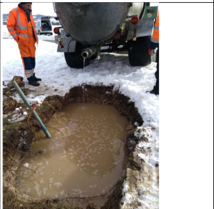
SCH 3: Nach der Einleitung von rd. 3.500 Liter in SCH 3
